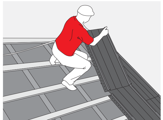
RYS. 27. UKŁADANIE KOLEJNEGO PANELU NA ZAKŁAD
