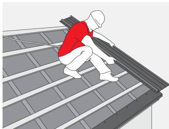
RYS. 16. UKŁADANIE PANELI DACHOWYCH
