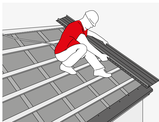
OBR. 16. UKLÁDÁNÍ STŘEŠNÍCH PANELŮ
