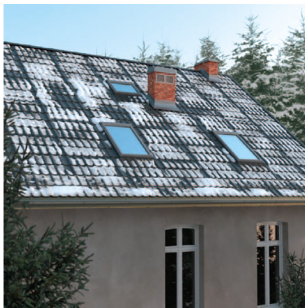
1.3. Příklad výskytu tepelných mostů - rozbředlý sníh v místech prostupu tepla krokviemi na střeše.
