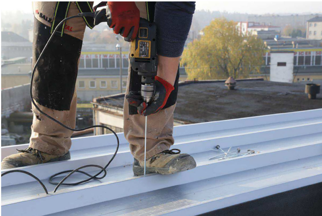
Schéma upevňování panelů
