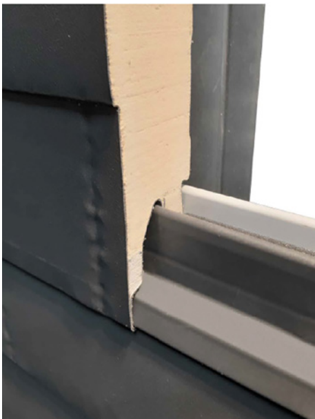
I Detail spoje panelů
