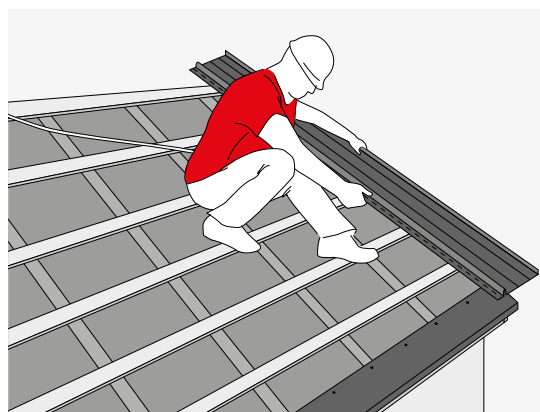
RYS. 16. UKŁADANIE PANELI DACHOWYCH
