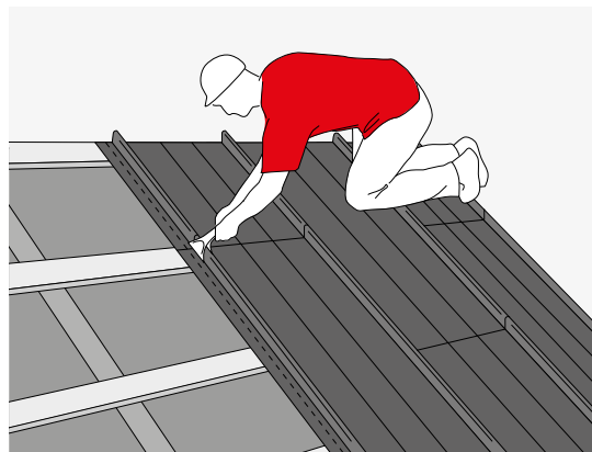
RYS. 30. ZACISKANIE ZAMKA PANELI W ZAKŁADACH
