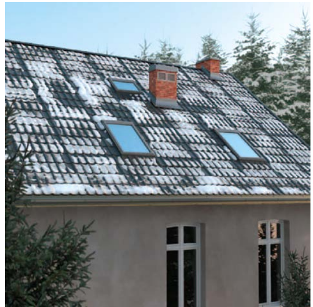
1.3. Przykład występowania mostków cieplnych – stopiony śnieg w miejscach przenikania ciepła przez krokwie na dachu.
